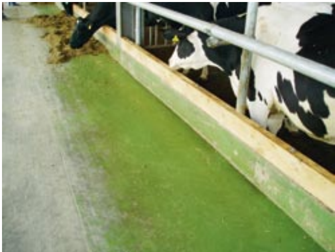
Bild 6: Beschichtung im Bereich von Futtertrögen in der Rinderhaltung
