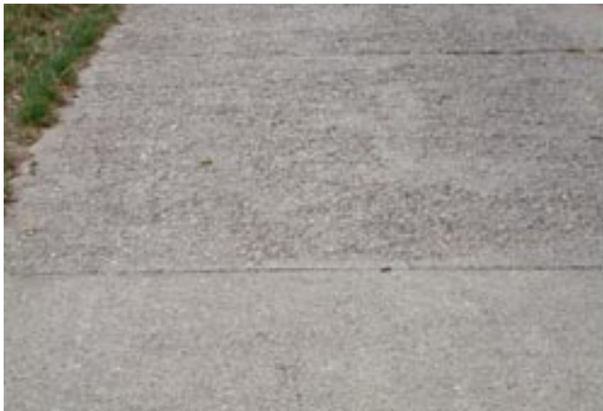
Bild 4: Oberflächenschaden, Entmörtelung
