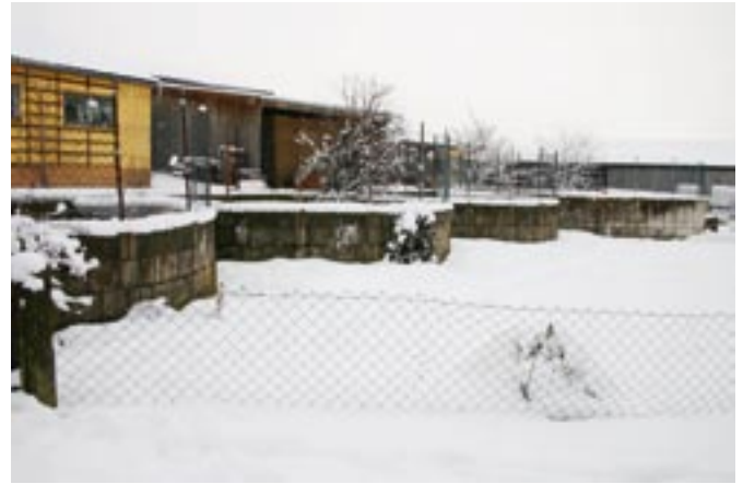
Bild 9: Zusätzliche Beanspruchung von Abdeckungen durch Schneelasten
