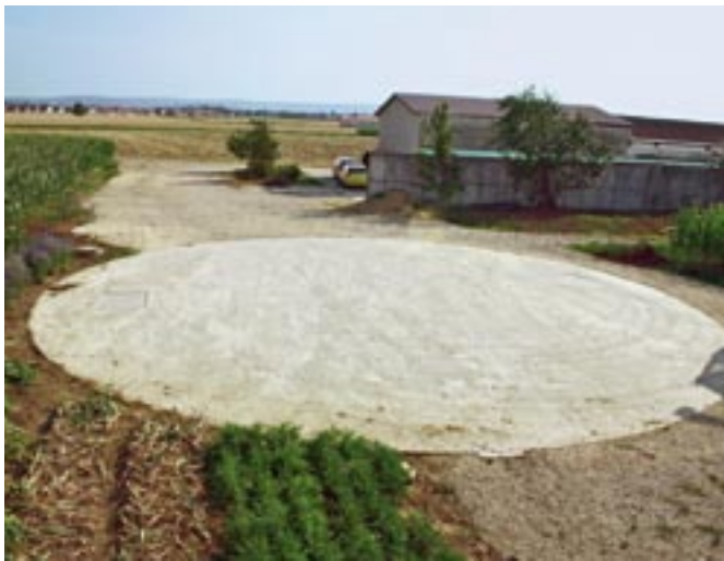
Bild 1: Güllegrube mit befahrbarer Betondecke
