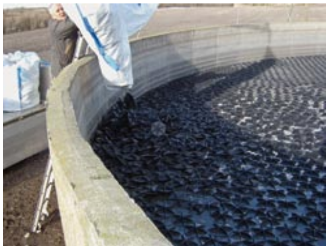
Bild 6: Einbringen der Schwimmkörper
