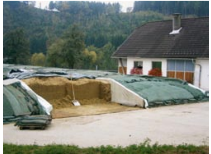
Bild 8: Schutz von Fahrsilowänden durch Folien
