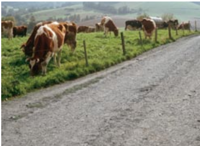
Bild 17: Gelungener Weg mit hydraulisch gebundener Tragdeckschicht HGTD
