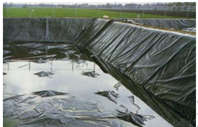
Bild 5: Beispiel einer Schwimmfolie
