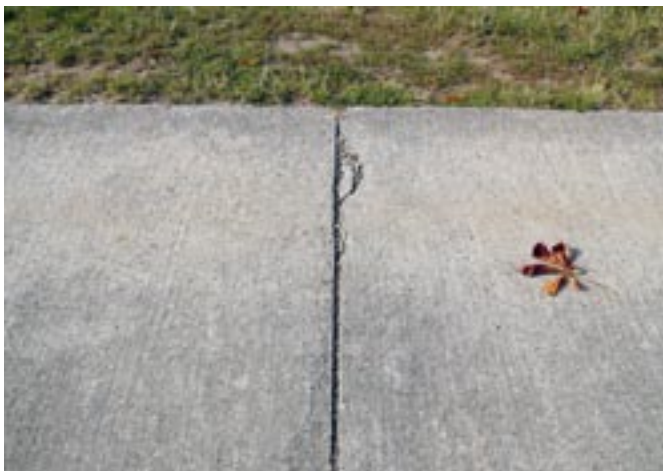
Bild 4: Oberflächenschaden, Entmörtelung
