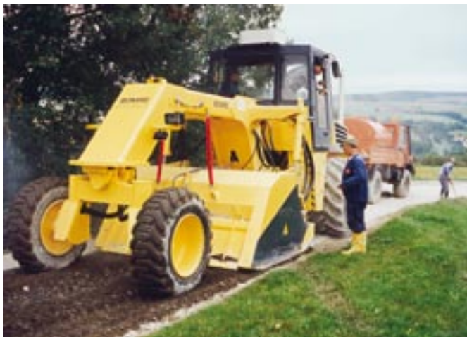
Bild 23: Einfräsen von Zement beim Fräsrecycling
