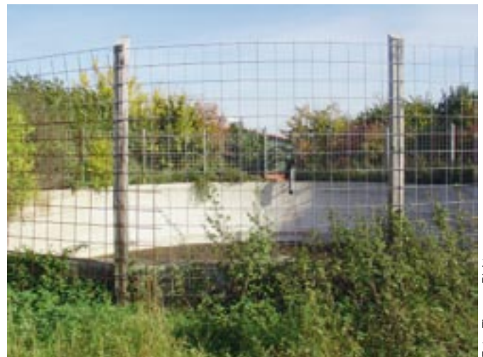
Bild 10: Absturzsicherung eines Güllebehälters
