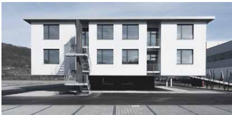
Beim Verwaltungsbau der Egon Elsäber Baubau wurden neben Elementdecken mit Betonkernaktivierung auch Thermowände eingesetzt.
